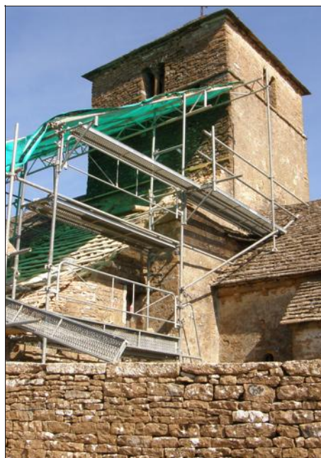
■ Une partie du toit en mauvais état est en cours de réparation. Photo Alain BOUDIER
